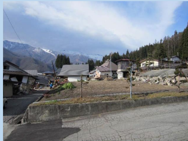
写真2：堀之内地区の被害
