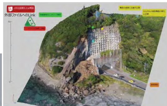
【斜面点検を想定したアノテーションの例】
