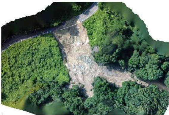
写真-1 UAVで撮影した被災状況全景
