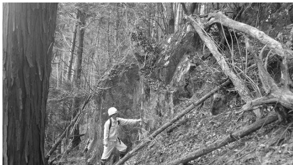
写真4 高さ2m程度の急崖斜面
