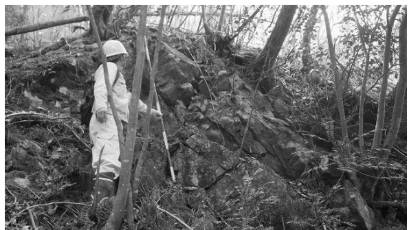
写真1 落石源となる急崖斜面の状況
