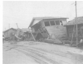
全壊した家屋 (玉野市八浜付近)
