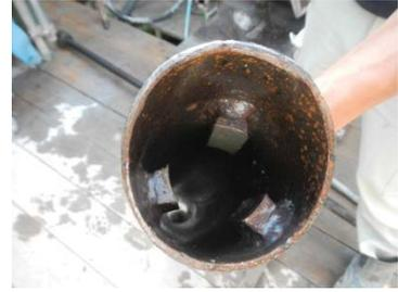
写真-7 ブレ止めの取付け
