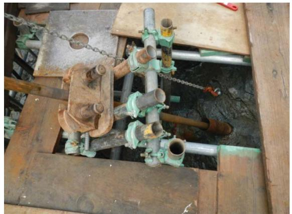
写真-8 アンカーボルト設置状況写真
