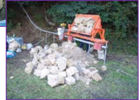
小割除去工施工例
