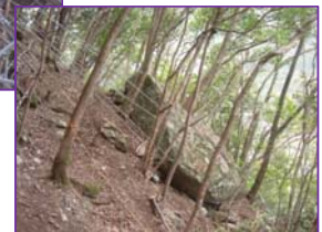
ロープ掛工施工例
