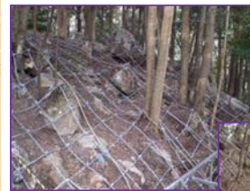
ロープ伏工施工例
