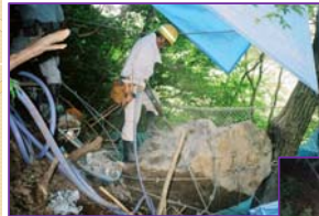
小割除去工施工例
