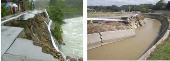
兼用護岸の崩壊 熱道湯温泉線(岐阜県 呂市小坂町)
