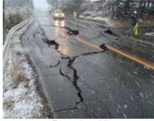
地震による路面の亀裂
