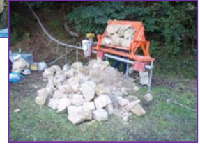
小割除去工施工例
