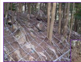
ロープ伏工施工例
